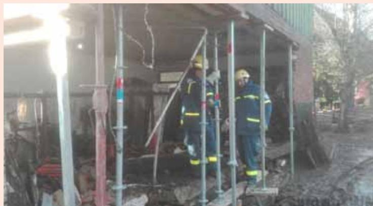
Abstütz- und Rüstarbeiten an der beschädigten Scheune
