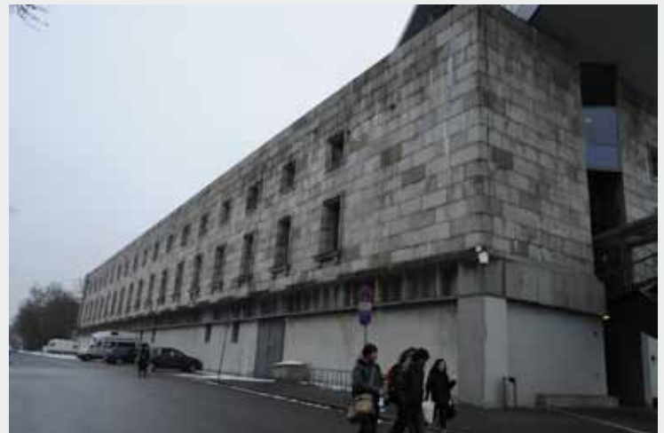
Gebäude des Reichstagsgeländes
