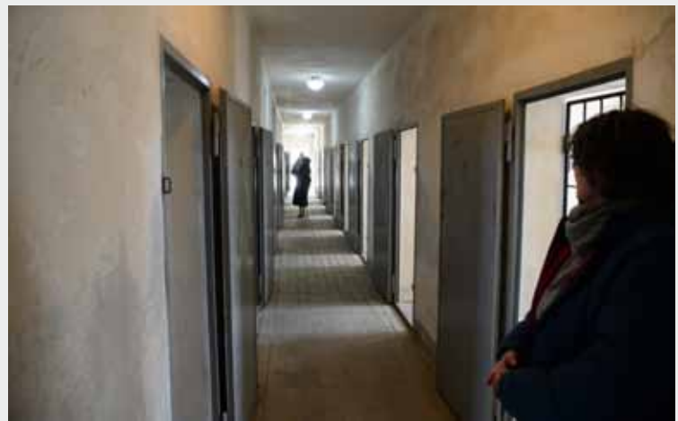
Ein langer dunkler Gang führt auf den Hof vorbei an den Einpersonenzellen mit schweren Holztüren.
