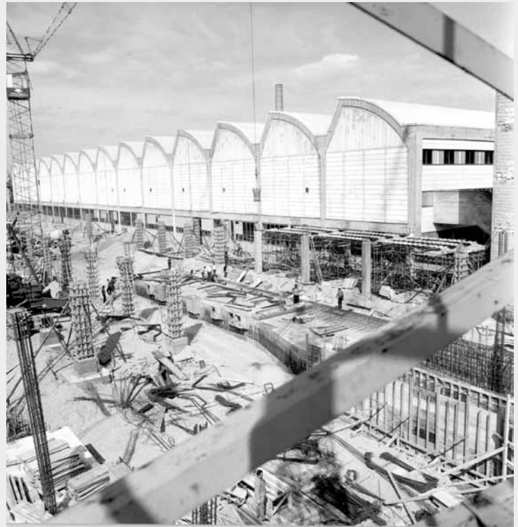
1958 fand die Grundsteinlegung für das Auto-Union-Werk an der Ettlinger Straße in Ingolstadt statt – hier eine Aufnahme der Baustelle des Presswerks.
