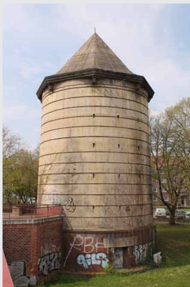
Hochbunker in Hannover-Linden
