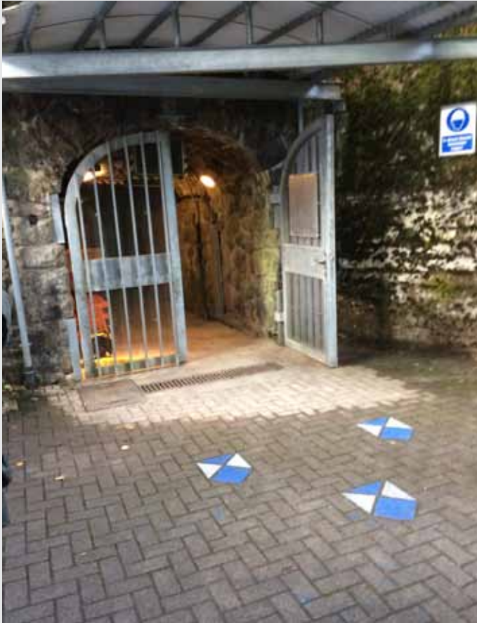
Eingang zum „Babarastollen“ in Oberried
