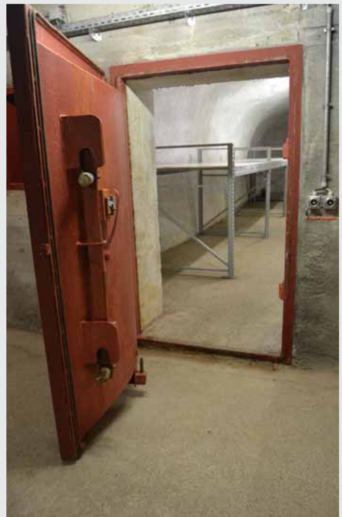
Im Berg ist der Bunker durch schwere Stahltüren gesichert
