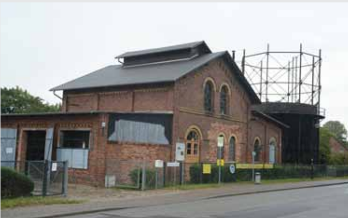
Eines der letzten Gaswerke als Museum in Neustadt/Dosse
