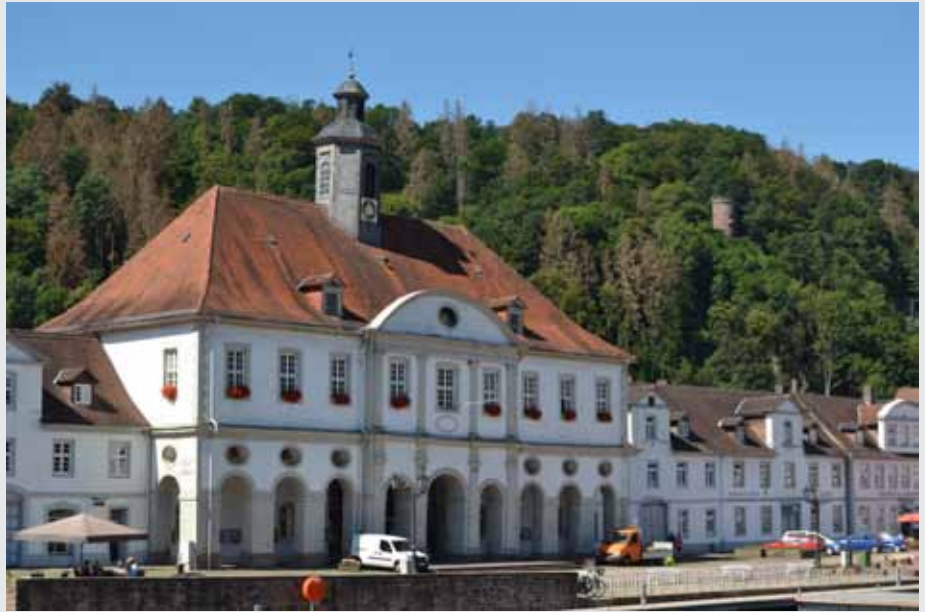
Packhaus („Altes Rathaus“), 1715–1718 erbaut, mit Hafenbecken des Landgraf-Carl-Kanals
